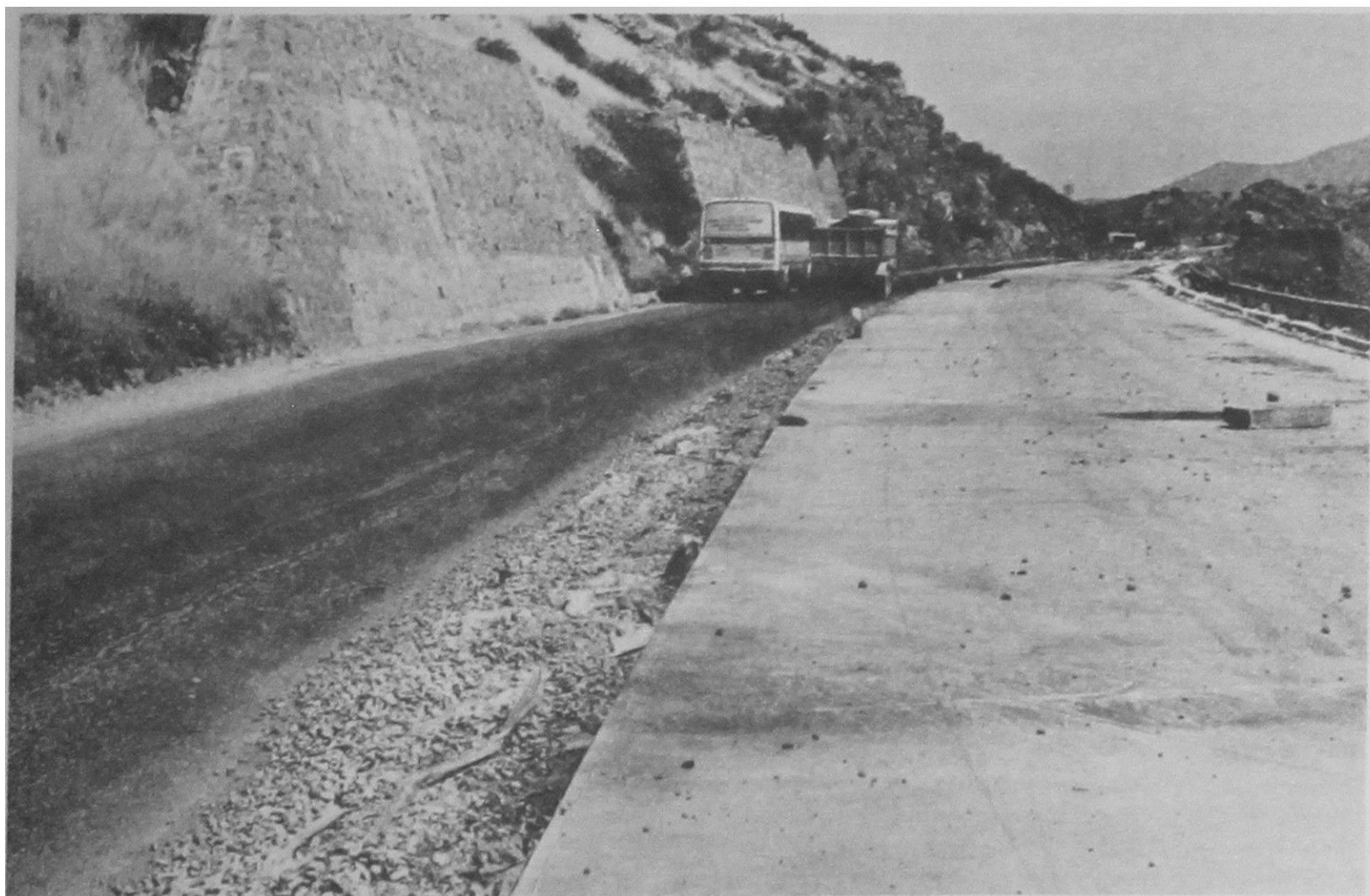
Tramo de pavimento de hormigón recién terminado.
